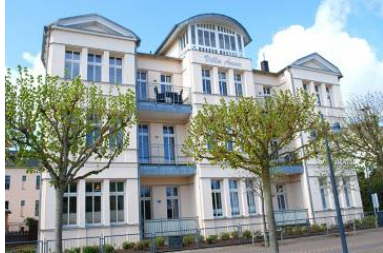
Blick von der Strandpromenade auf das Haus.
