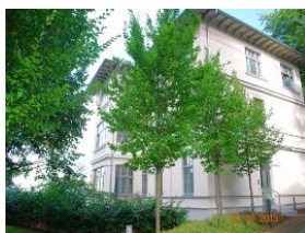
Blick von der Zufahrt Richtung Haus.
